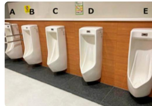
当社が受託する3棟のビルにて、微生物製剤「バイオクリーンズ」を用いた配管清掃の実証実験を実施しました。高圧洗浄や強酸性薬剤を使用せず、尿石詰まりやアンモニア臭、衛生害虫の発生を大幅に抑制。作業負担や配管損傷リスクの軽減に加え、環境負荷の低減にもつながることが確認されました。自然由来の微生物による安全性と、継続使用による長期的なコスト削減効果が期待されており、他物件への導入も進めています。
